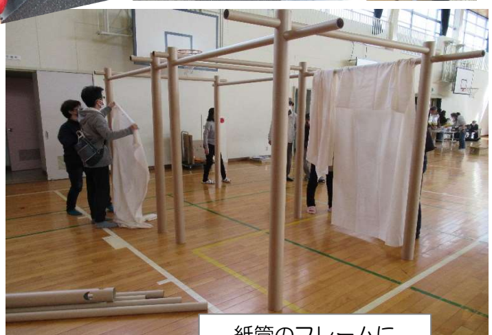
紙管のフレームに布をかけた間仕切り
